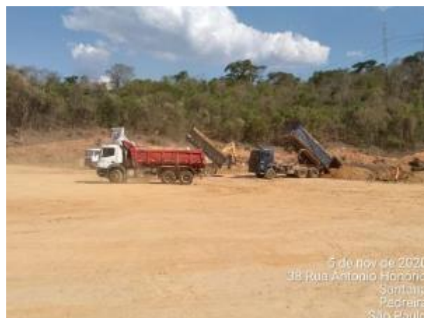
Foto 434 – Movimentação de terra na margem esquerda. (Data:05/11/2020)
