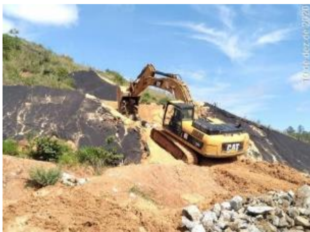
Foto 326 – Limpeza de cacimba e regularização de talude do bota-fora I ME. (Data:10/12/2020)
