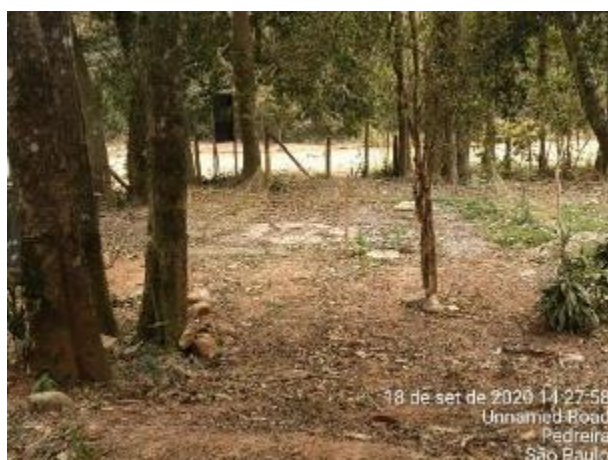
Foto 356– Biodigestor 1 no canteiro administrativo. (Data:18/09/2020)
