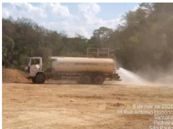
Foto 370 – Umectação nas vias internas. (Data:05/11/2020)
