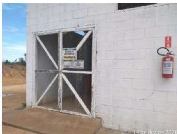
Foto 80 – Baía de resíduos perigosos no canteiro operacional. (Data:14/12/2020)
