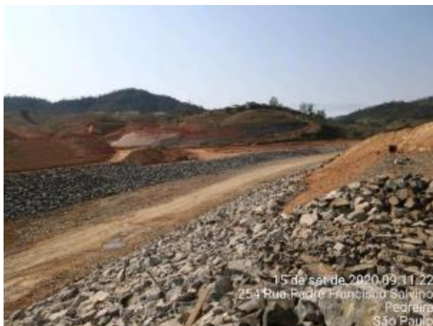
Foto 266 – Canal de desvio com enrocamento implantado em suas margens. (Data:15/09/2020)
