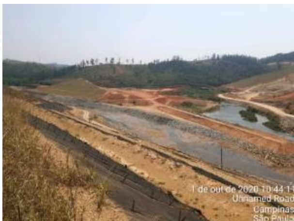
Foto 314 – Inspeção bota-fora I M.E. (Data:01/10/2020)
