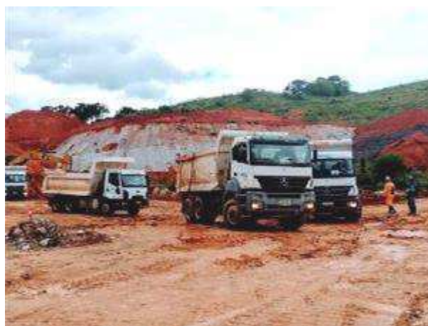
Foto 446 – Movimentação de terra na margem direita. (Data:11/12/2020)
