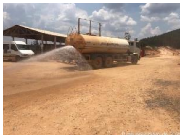
Foto 371 – Umectação nas vias externas. (Data:11/11/2020)
