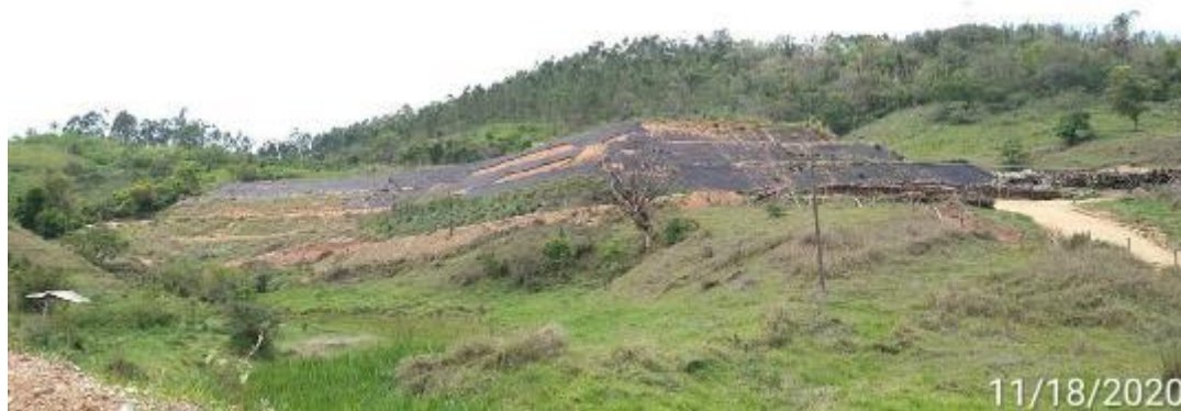
Foto 452 – Bota-fora III Margem Direita. (Data:18/11/2020)
