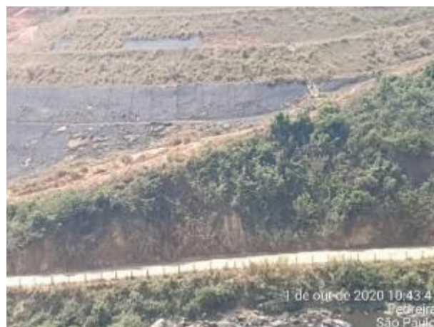
Foto 311 – Inspeção bota-fora II M.D. (Data:01/10/2020)
