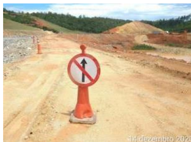
Foto 265 – Sinalização de sentido proibido na margem esquerda. (Data:14/12/2020)
