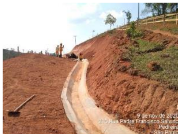
Foto 282 – Drenagem no talude do acesso da MD03. (Data:09/11/2020)
