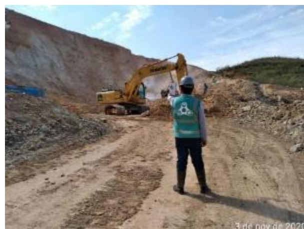
Foto 383 – Monitoramento de fumaça preta em escavadeira hidráulica. (Data:03/11/2020)
