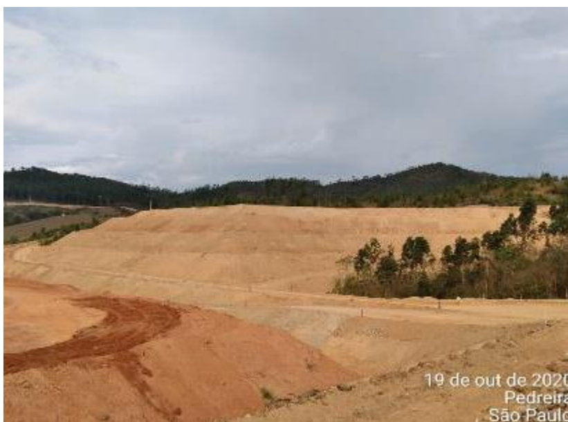
Foto 458 – Bota-fora II A margem esquerda. (Data:19/10/2020)
