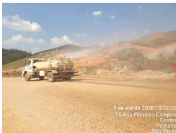
Foto 364 – Umectação nas vias internas. (Data:05/10/2020)
