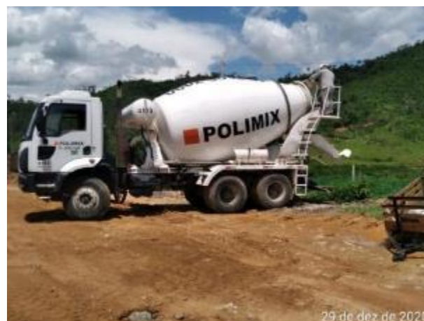
Foto 343 – Lavagem da calha de betoneira. (Data:29/12/2020)
