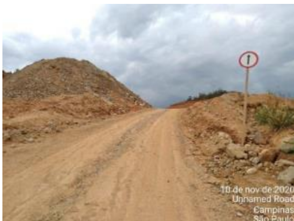
Foto 258 – Sinalização de sentido obrigatório em via interna na margem esquerda. (Data:10/11/2020)
