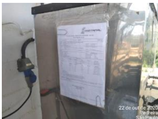
Foto 130 – Laudo de potabilidade da água disponível nos bebedouros do canteiro operacional. (Data:22/10/2020)
