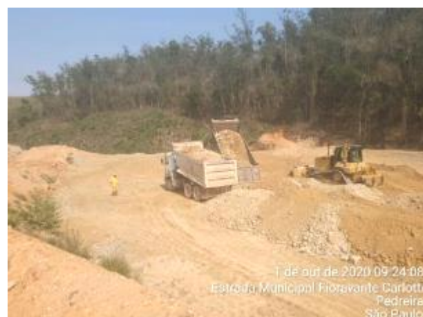
Foto 425 – Movimentação de terra na margem esquerda. (Data:01/10/2020)
