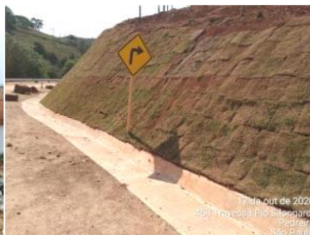
Foto 277 – Talude protegido com grama, e canaleta de drenagem no acesso MD03. (Data:17/10/2020)
