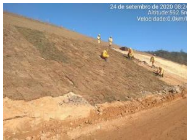
Foto 267 – Implantação de grama em placa em talude de corte ME. (Data:24/09/2020)
