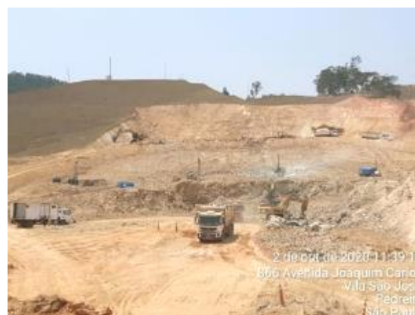
Foto 426 – Movimentação de terra e de desmonte de rocha ombreira direita. (Data:02/10/2020)
