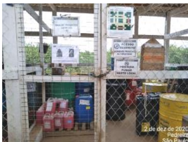
Foto 78 – Baía de produtos químicos no pátio da oficina mecânica. (Data:02/12/2020)
