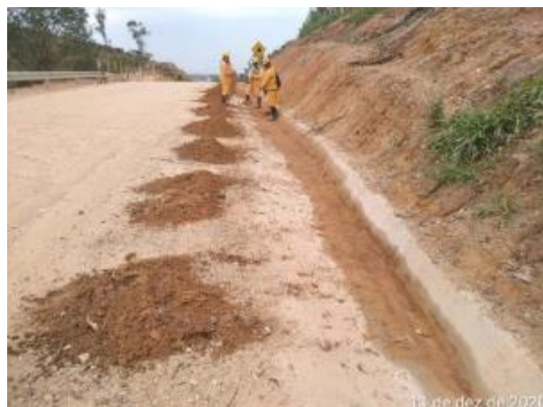
Foto 327 – Limpeza de canaleta do acesso MD.03. (Data:11/12/2020)
