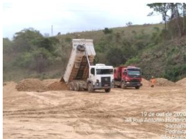
Foto 430 – Movimentação de terra na margem esquerda (Data:19/10/2020)
