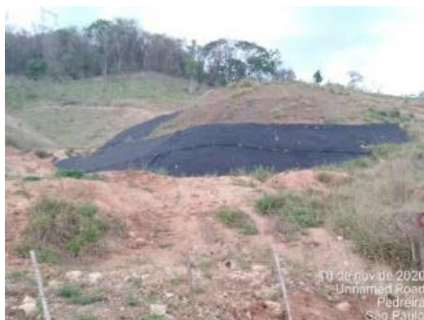
Foto 320 – Inspeção bota-fora IV M.D. (Data:10/11/2020)
