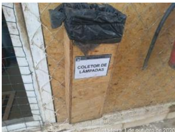
Foto 402 – Coletor de lâmpadas disponíveis no canteiro operacional. (Data:01/10/2020)
