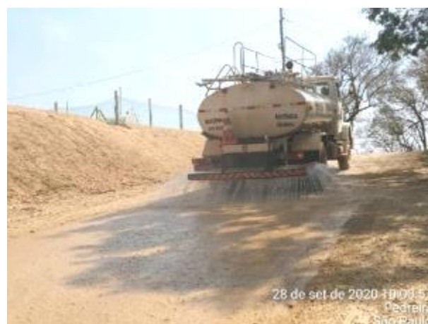
Foto 363 – Umectação nas vias externas. (Data:28/09/2020)
