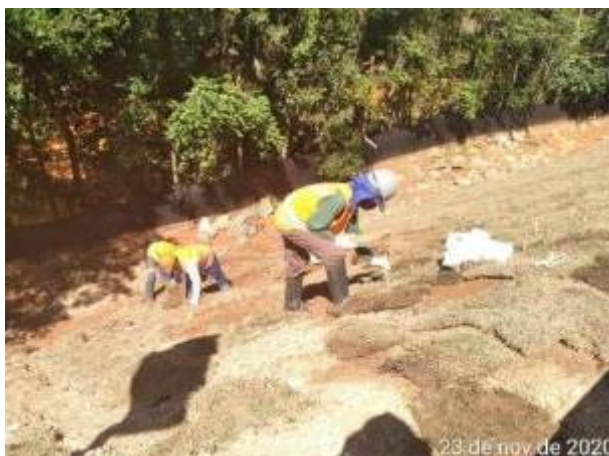
Foto 158 – Reaproveitamento de bambu para plantação de gramas em taludes. (Data:23/11/2020)
