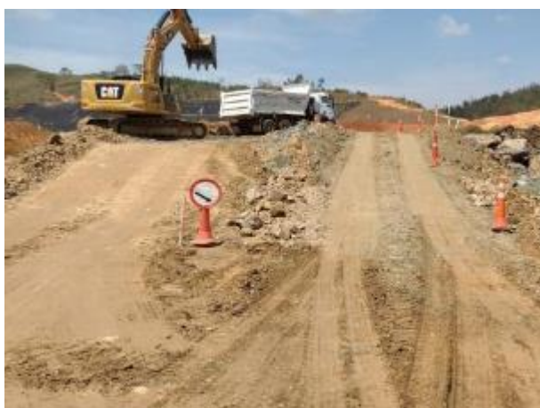
Foto 260 – Sinalização de sentido obrigatório em via interna na margem esquerda. (Data:11/11/2020)
