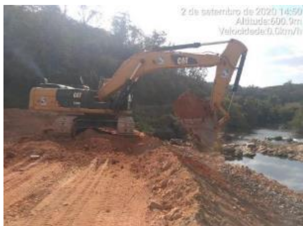
Foto 421 – Escavação do canal de desvio. (Data:02/09/2020)
