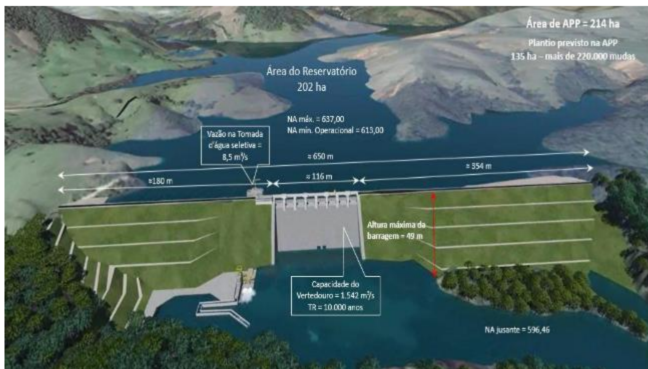
Figura 1 —Projeção da futura Barragem Pedreira
