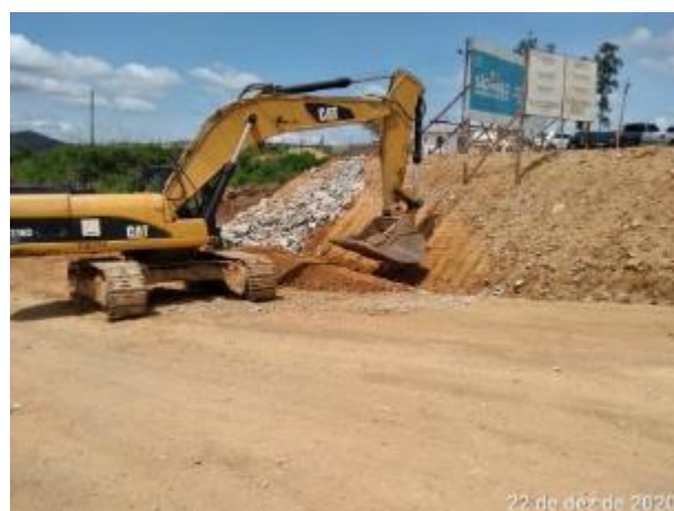
Foto 331 – Regularização de talude no acesso MD01. (Data:22/12/2020)
