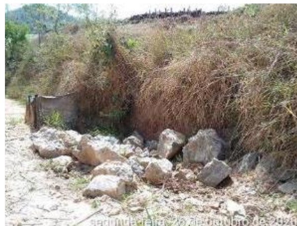
Foto 315 – Inspeção drenagem provisória existente em via externa. (Data:26/10/2020)
