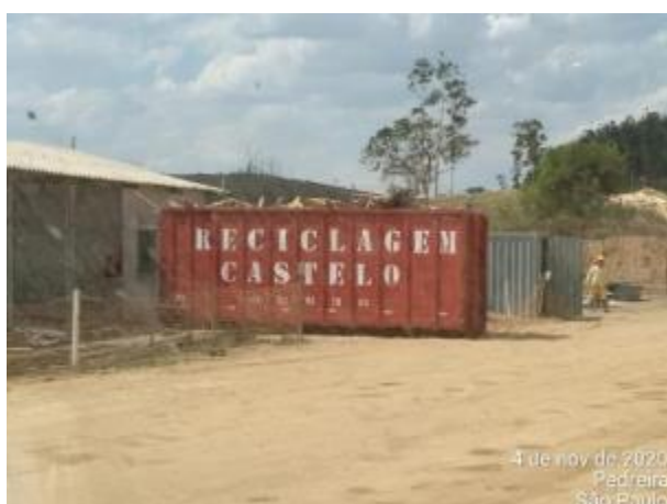
Foto 410 – Caçamba de madeira no canteiro operacional. (Data:04/11/2020)
