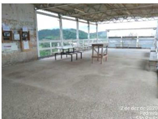
Foto 116 – Área de vivência limpa e organizada no canteiro operacional. (Data:02/12/2020)
