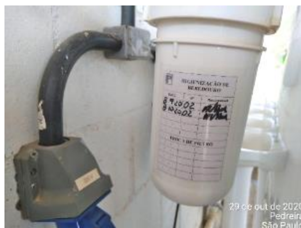
Foto 131 – Controle de troca de filtro do bebedouro 3 no canteiro operacional. Data:29/10/2020)
