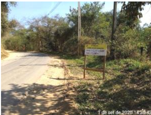
Foto 178 – Placa informativa sobre o desmonte de rocha na estrada municipal de Pedreira. (Data:01/09/2020)
