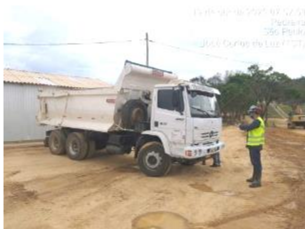
Foto 166– Inspeção em caminhão. (Data:19/10/2020)
