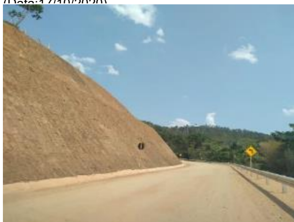
Foto 279 – Talude no acesso da MD03 protegido com grama. (Data:30/10/2020)
