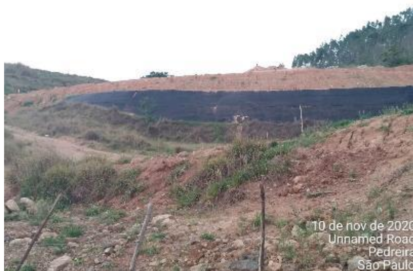
Foto 453 – Bota-fora IIIA Margem Direita. (Data:10/11/2020)
