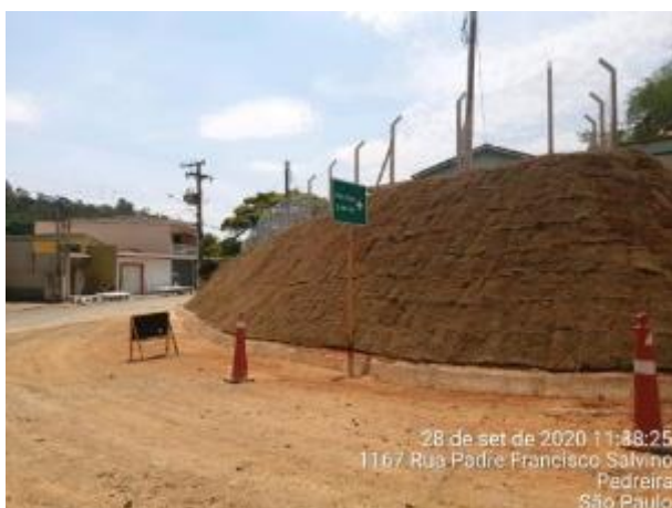
Foto 270 – Talude no acesso MD 03 gramado. (Data:28/09/2020)
