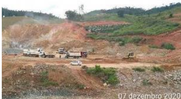
Foto 445 – Movimentação de terra e rocha na margem direita. (Data:07/12/2020)
