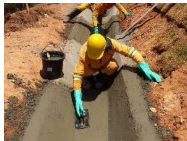
Foto 289 – Construção de drenagem definitiva no acesso da MD03. (Data:01/12/2020)
