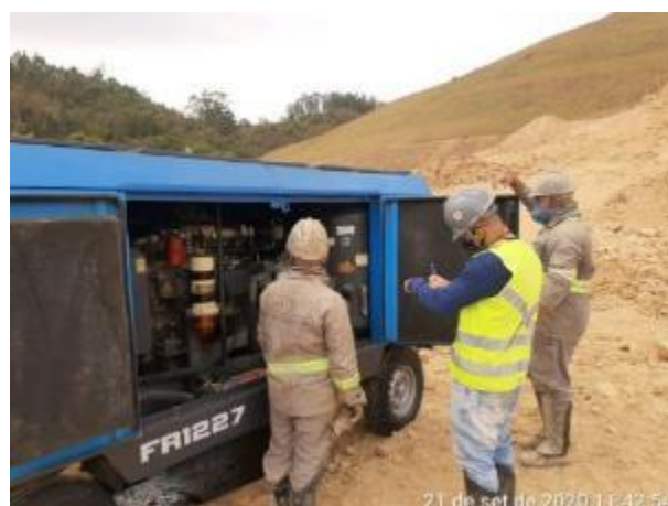
Foto 165– Inspeção em compressor. (Data:21/09/2020)
