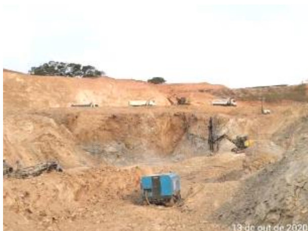
Foto 427 – Movimentação de terra na margem direita. (Data:13/10/2020)
