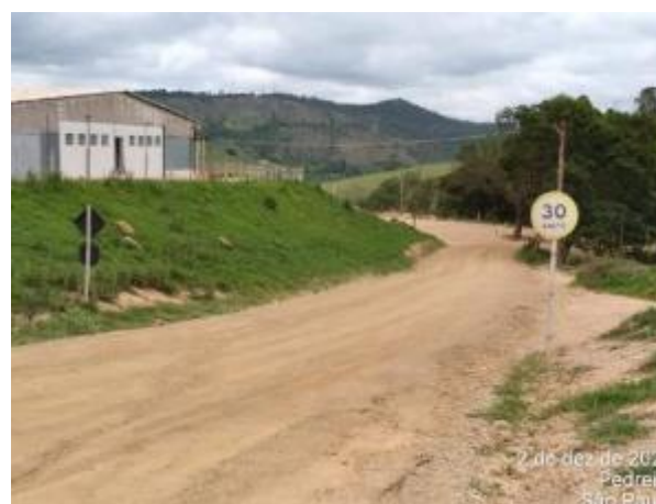
Foto 263 – Sinalização de limite de velocidade em via interna na margem direita. (Data:02/12/2020)
