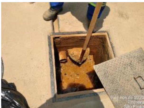
Foto 342 – Inspeção e limpeza da caixa SÃO 1 da área de abastecimento. (Data:09/11/2020)
