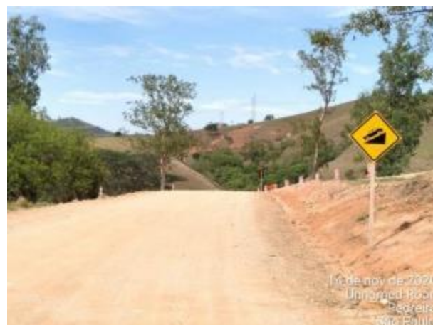
Foto 243 – Sinalização de acrive a frente, no desvio da estrada municipal. (Data:14/11/2020)
