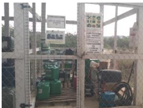
Foto 68 – Baía de produtos químicos 1 no pátio de oficina mecânica. (Data:30/09/2020)
