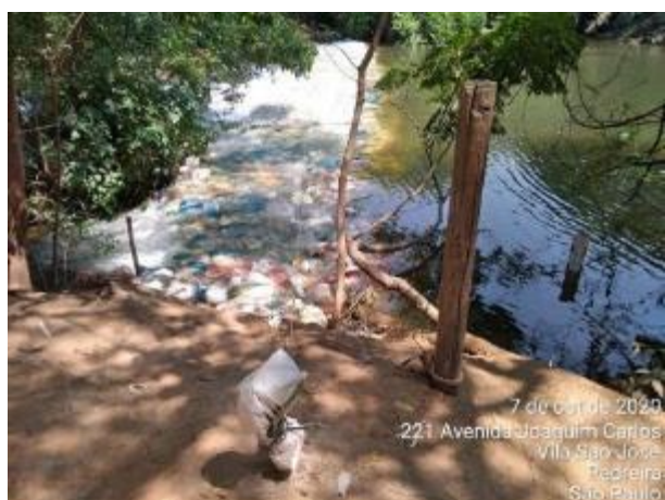
Foto 475 – Soleira finalizada. (Data:07/10/2020)
