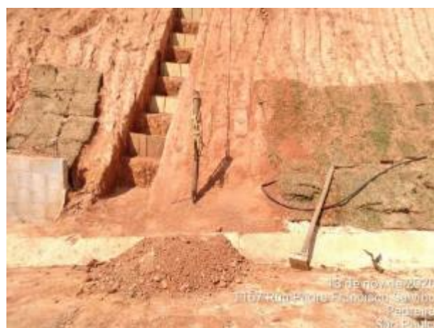
Foto 284 – Construção de escada hidráulica no talude da MD03. (Data:13/11/2020)
