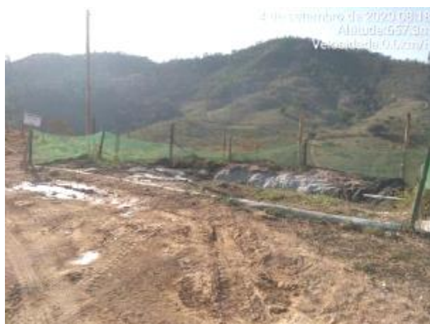
Foto 336 – Área de lavagem para calha da betoneira. (Data:04/09/2020)
