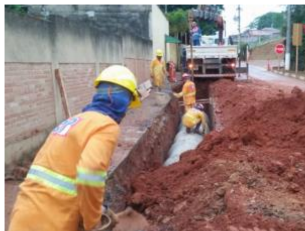
Foto 281 – Drenagem definitiva na rua Padre Francisco Salvino. (Data:30/10/2020)
