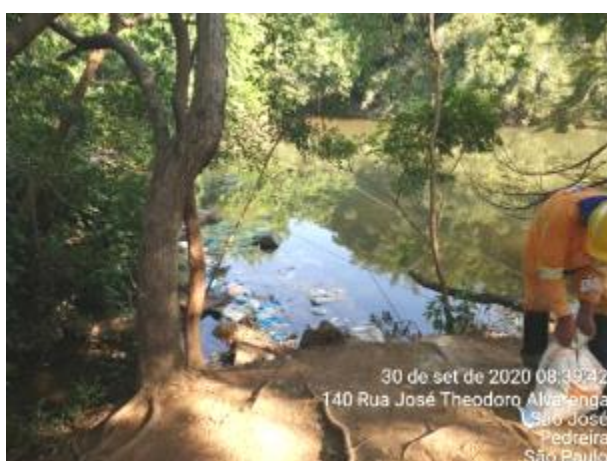
Foto 469 – Execução da atividade. (Data:30/09/2020)
