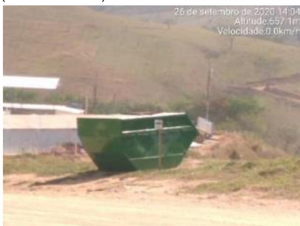
Foto 400 – Caçamba de resíduo comum instalada no canteiro operacional. (Data:26/09/2020)
