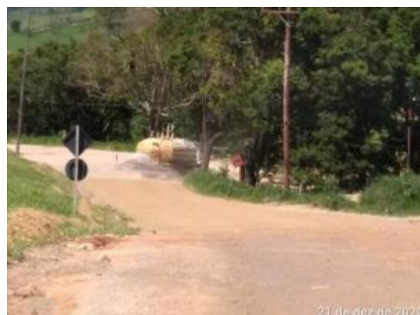
Foto 375 – Umectação nas vias internas. (Data:21/12/2020)
