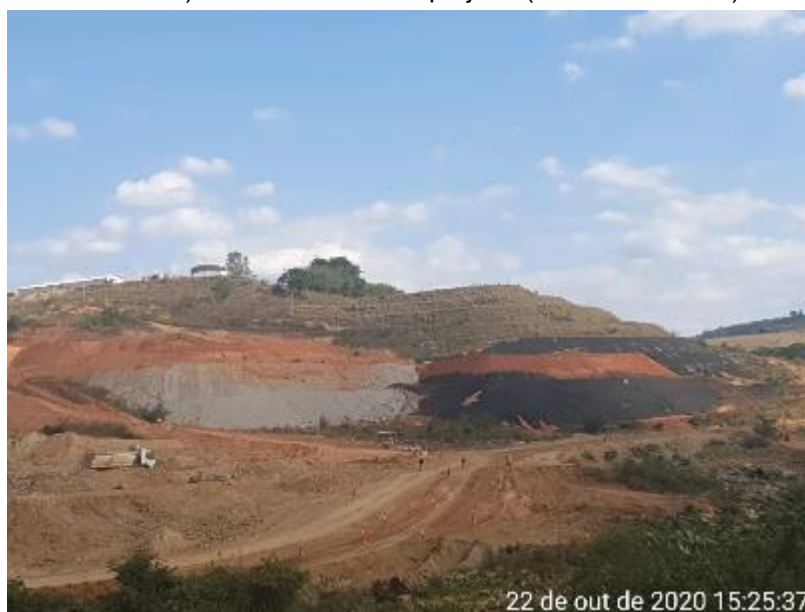
Foto 449 – Bota-espera Margem Direita. (Data:22/10/2020)
