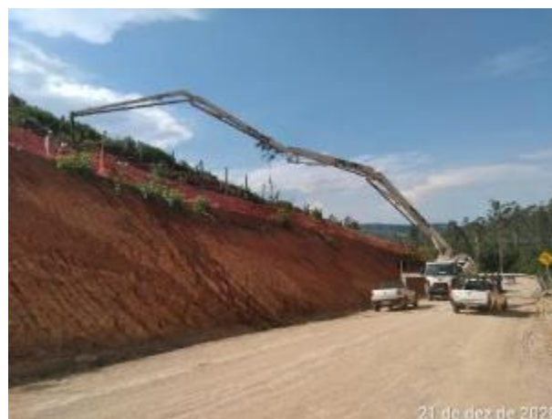
Foto 295 – Concretagem de canaleta de crista em talude da MD03. (Data:21/12/2020)
