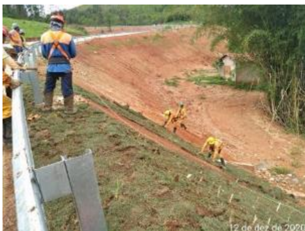
Foto 292 – Talude da MD 03 sendo gramado. (Data:12/12/2020)
