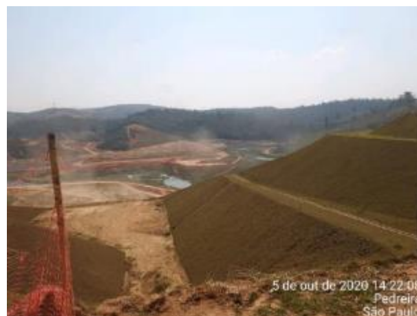
Foto 275 – Talude de corte protegido com grama na margem direita. (Data:05/10/2020)
