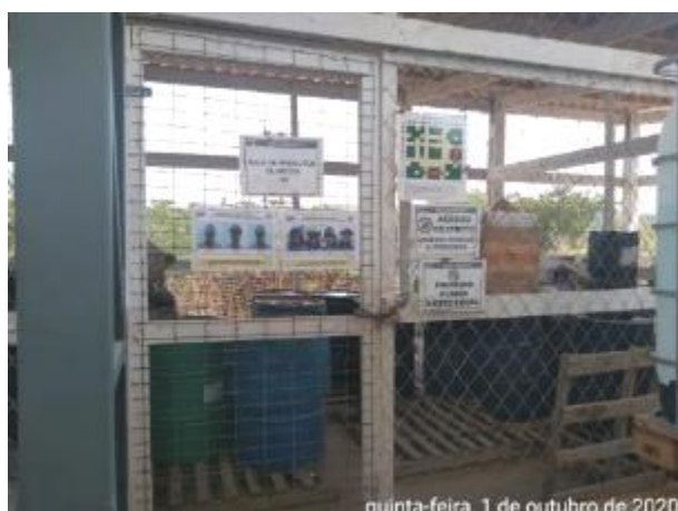
Foto 70 – Baía de produtos químicos 1 no pátio de oficina mecânica. (Data:01/10/2020)
