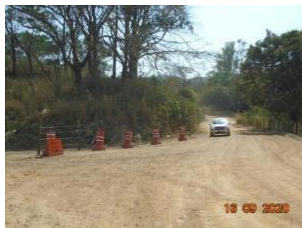
Foto 237 – Sinalização indicando o acesso ao desvio da estrada municipal. (Data:16/09/2020)
