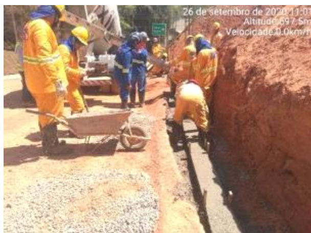
Foto 268 – Implantação de sistema de drenagem na MD03. (Data:26/09/2020)
