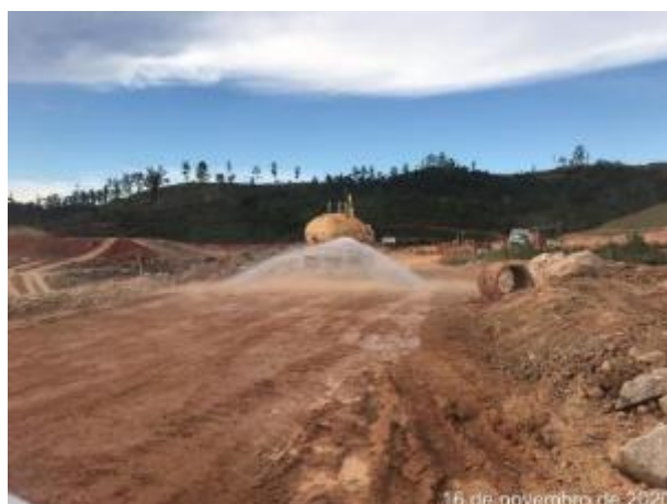
Foto 372 – Umectação nas vias internas (Data:16/11/2020)
