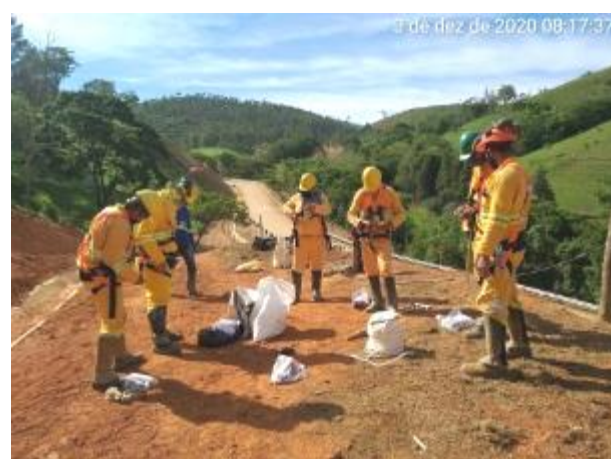
Foto 221 – Treinamento de trabalho em altura (NR-35). (Data:03/12/2020)
