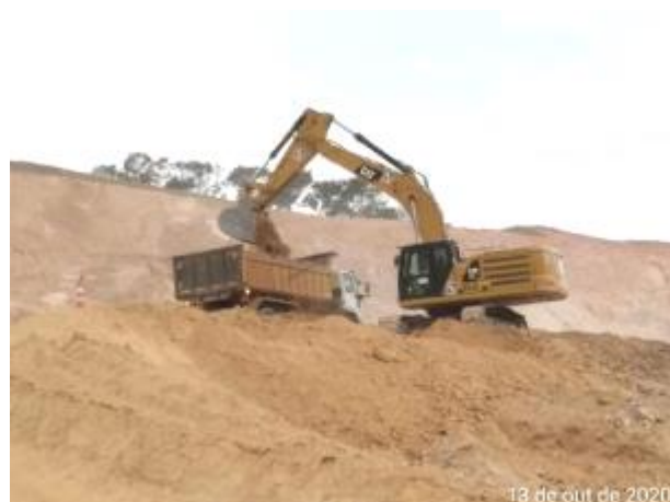
Foto 428 – Movimentação de terra na margem direita. (Data:13/10/2020)
