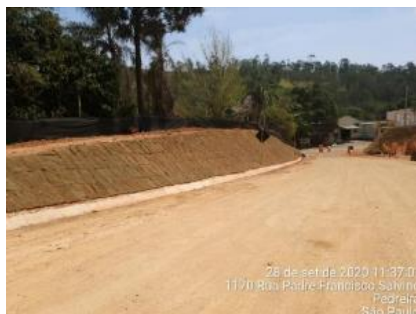
Foto 269 – Talude no acesso MD 03 gramado. (Data:28/09/2020)
