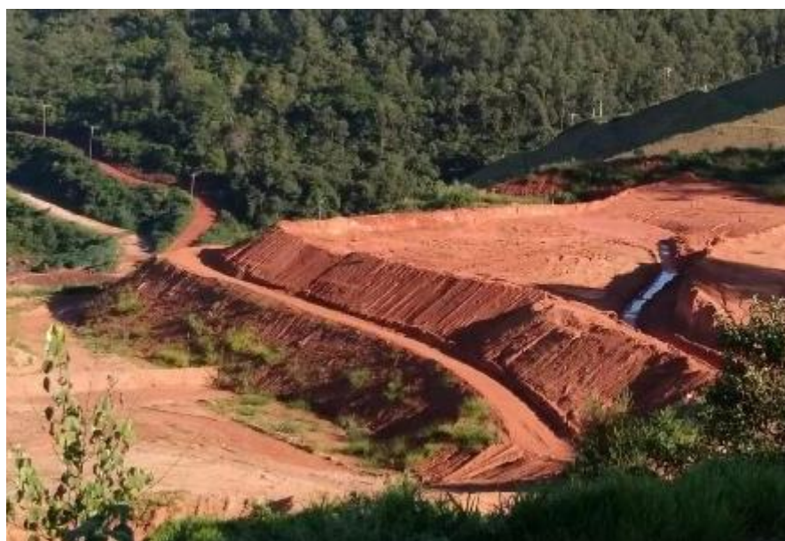
Foto 450 – Bota-fora I Margem Direita. (Data:28/12/2020)
