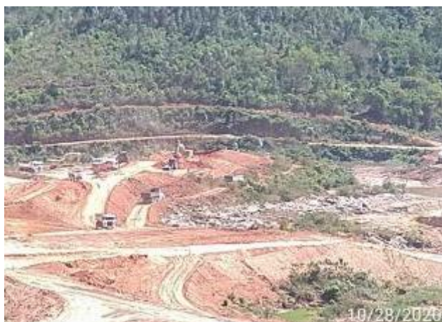
Foto 431 – Movimentação de terra do projeto. (Data:28/10/2020)
