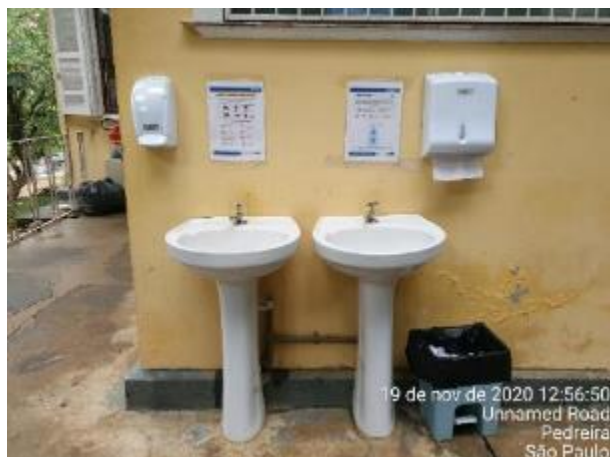
Foto 111 – Estrutura para higienização de mãos no refeitório no canteiro administrativo. (Data:19/11/2020)
