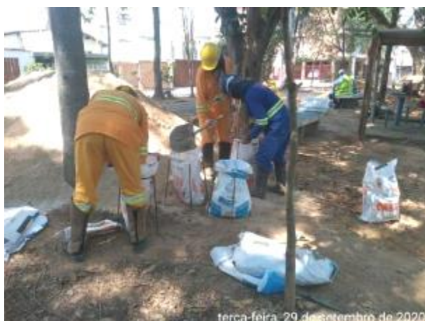
Foto 465 – Início da montagem das sacarias. (Data:29/09/2020)
