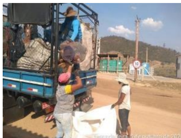
Foto 405 – Retirada de resíduos recicláveis no canteiro operacional. (Data:05/10/2020)
