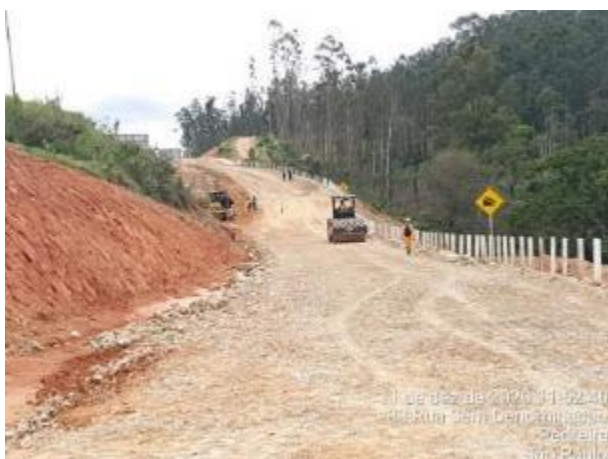
Foto 328 – Regularização do acesso da MD01. (Data:11/12/2020)
