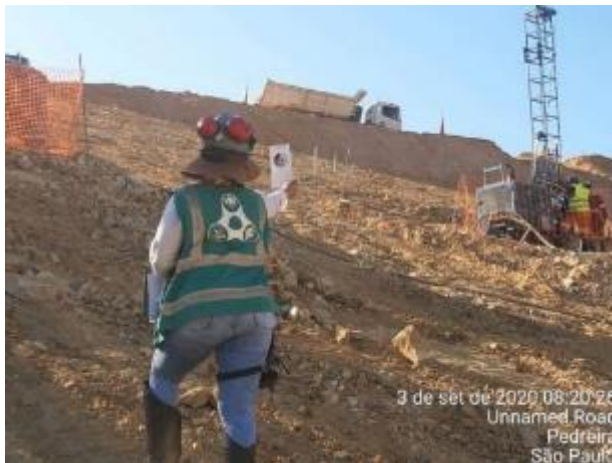
Foto 376 – Identificação da inspeção de fumaça preta em equipamento. (Data:03/09/2020)
