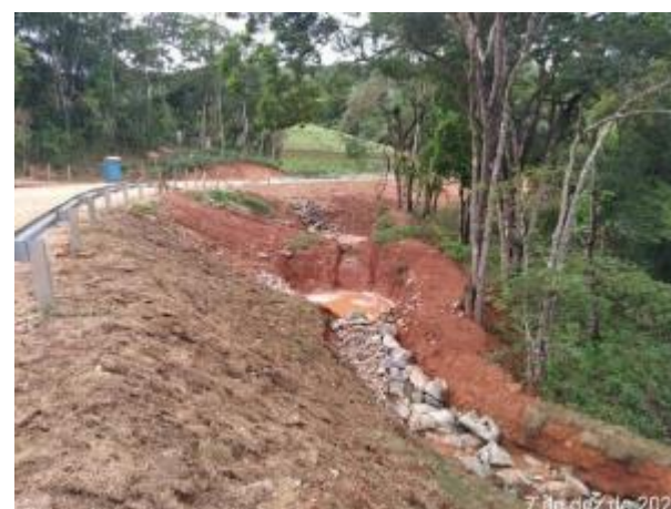
Foto 291 – Implantado drenagem provisória no acesso MD 03, na estrada municipal. (Data:07/12/2020)
