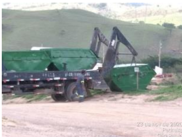
Foto 414 – Troca da caçamba de resíduo comum no canteiro operacional. (Data:23/11/2020)
