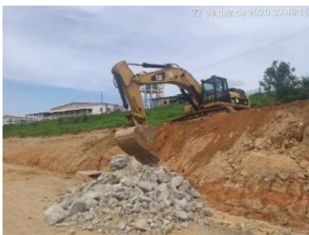
Foto 330 – Regularização de talude no acesso MD01. (Data:22/12/2020)
