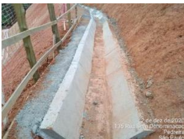
Foto 290 – Instalação de drenagem definitiva em talude na MD 03. (Data:02/12/2020)
