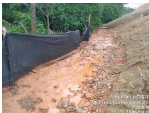
Foto 322 – Contenção ambiental no acesso MD 03. (Data:03/12/2020)
