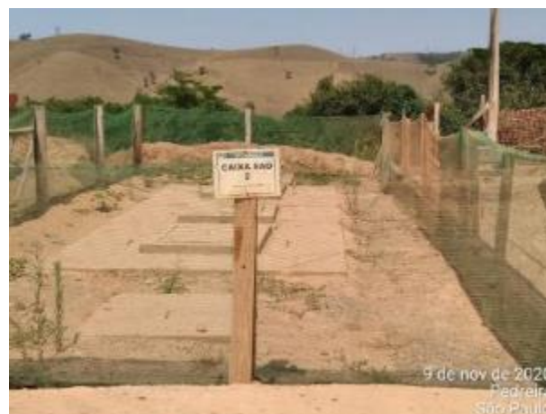
Foto 341 – Caixa SAO 2 no pátio de equipamentos. (Data:09/11/2020)
