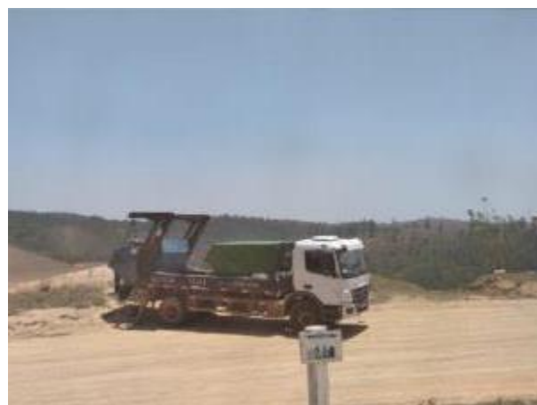
Foto 409 – Troca da caçamba de resíduo comum no canteiro operacional. (Data:29/10/2020)
