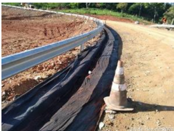
Foto 294 – Implantação de drenagem definitiva no acesso MD03. (Data:18/12/2020)
