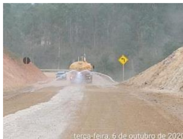
Foto 365 – Umectação nas vias externas. (Data:06/10/2020)
