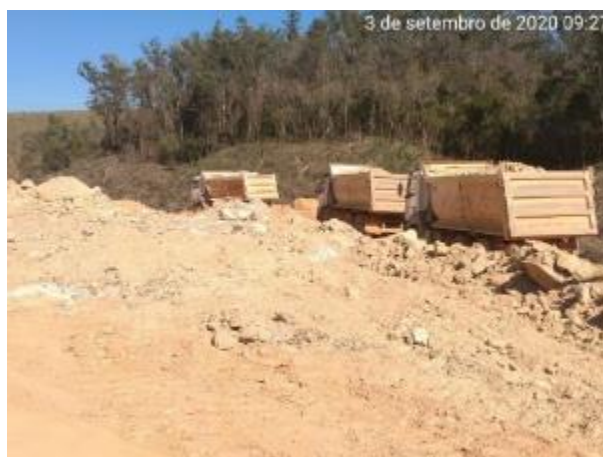
Foto 422 – Movimentação do material de desmonte. (Data:03/09/2020)
