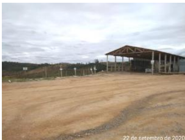
Foto 96 – Área do canteiro operacional limpa e organizada. (Data:22/09/2020)
