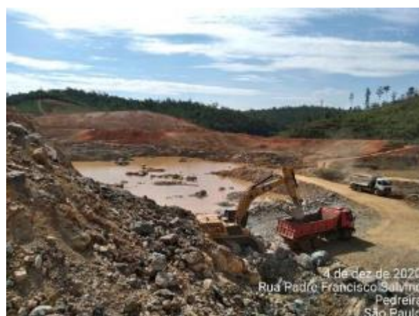
Foto 442 – Movimentação de rocha e terra na margem direita. (Data:04/12/2020)
