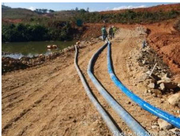
Foto 148 – Implantação da ensecadeira de jusante. (Data:21/10/2020)
