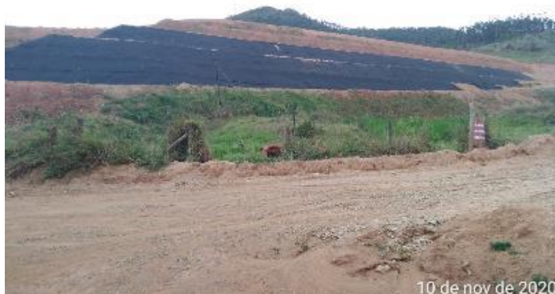
Foto 456 – Bota-fora VII margem direita. (Data:10/11/2020)
