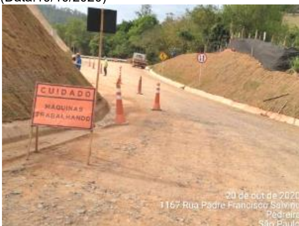
Foto 240 – Sinalização informando e isolando a atividade com máquinas no início do acesso MD03. (Data:20/10/2020)
