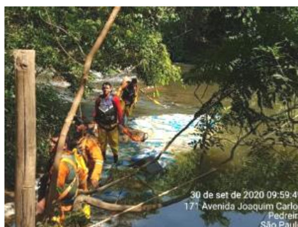
Foto 470 – Execução da atividade. (Data:30/09/2020)
