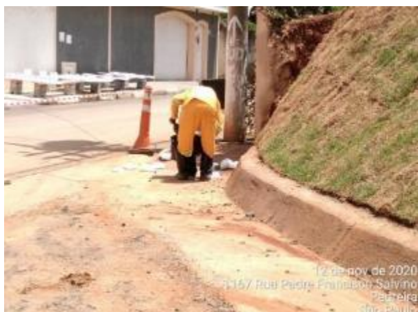
Foto 112 – Limpeza na frente de serviço do acesso MD03. (Data:12/11/2020)
