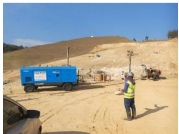
Foto 377 – Monitoramento de fumaça preta em equipamento. (Data:21/09/2020)
