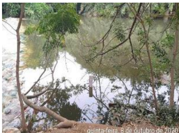
Foto 477 – Soleira finalizada. (Data:08/10/20)
