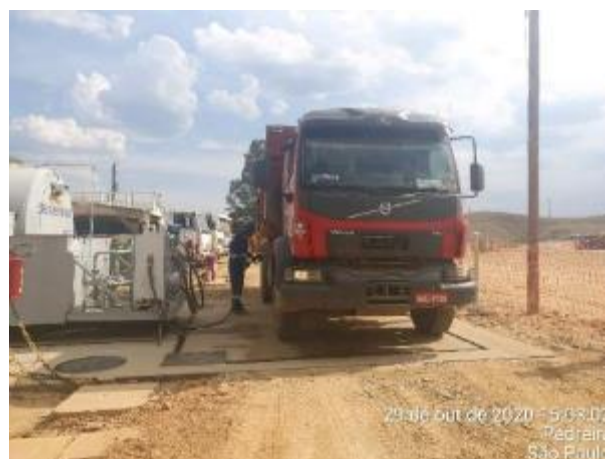
Foto 73– Abastecimento de equipamento no empreendimento. (Data:29/10/2020)
