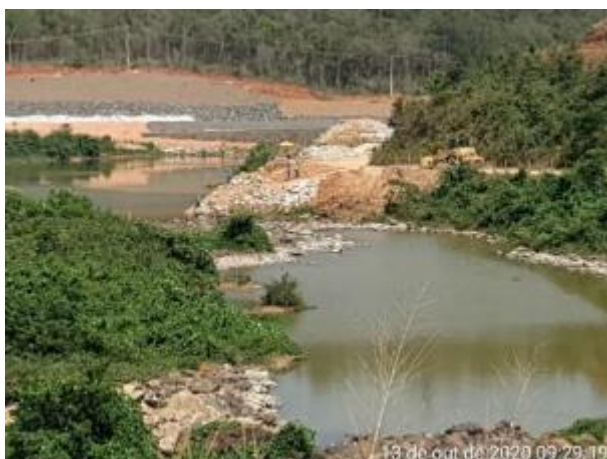
Foto 146 – Implantação da ensecadeira de jusante. (Data:13/10/2020)
