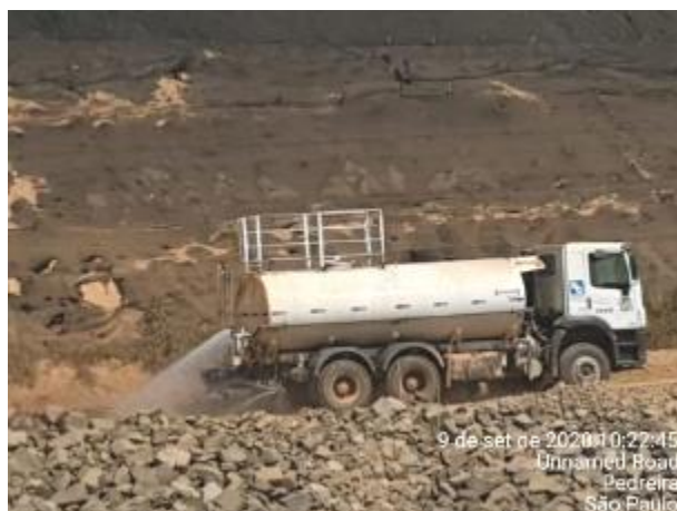
Foto 360 – Umectação nas vias internas. (Data:09/09/2020)
