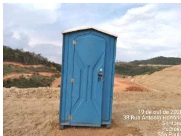
Foto 351 – Banheiro químico instalado na frente de serviço. (Data:19/10/2020)
