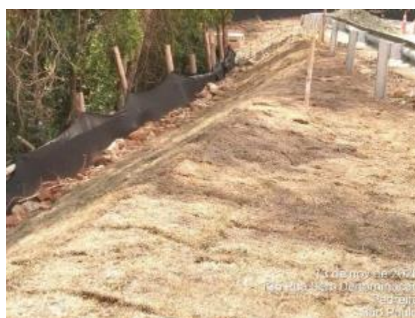
Foto 283 – Talude gramado no acesso da MD03. (Data:13/11/2020)
