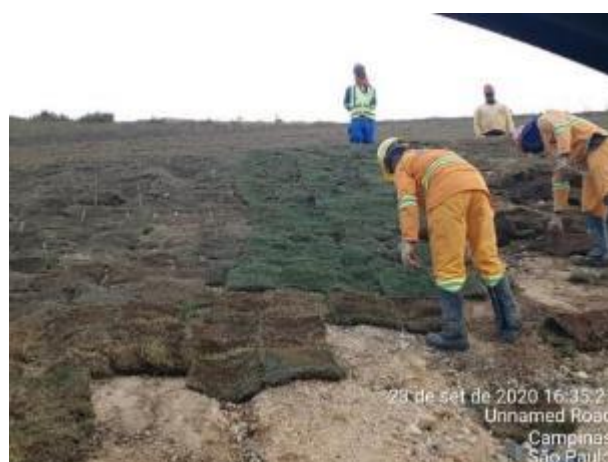
Foto 272 – Implantação de grama em talude do acesso MD03. (Data:23/09/2020)
