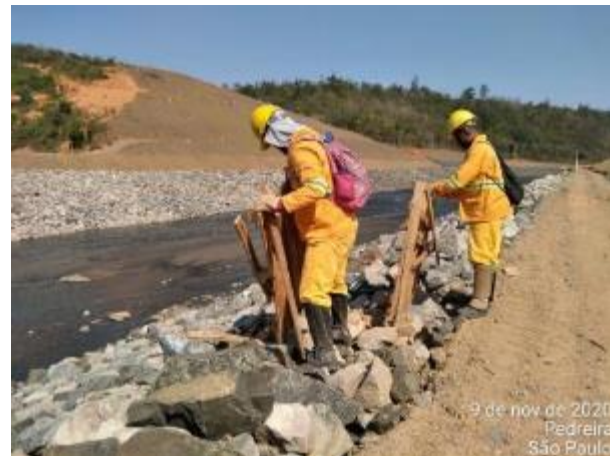
Foto 109 – Retirada de resíduo de madeira próximo ao canal de desvio. (Data:09/11/2020)
