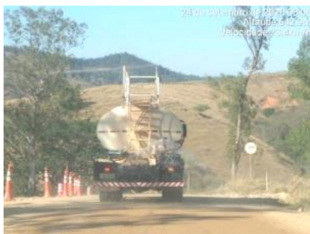
Foto 362 – Umectação nas vias internas. (Data:24/09/2020)
