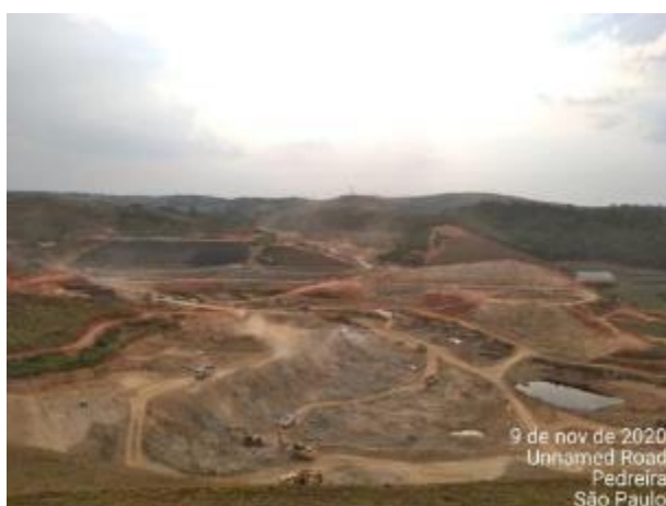
Foto 435 – Movimentação de terra do projeto. (Data:09/11/2020)
