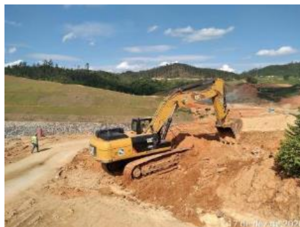
Foto 293 – Implantação de cacimba na ME, próximo ao bota-espera do núcleo ME. (Data:17/12/2020)
