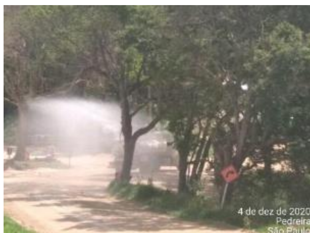
Foto 374 – Umectação nas vias internas. (Data:04/12/2020)
