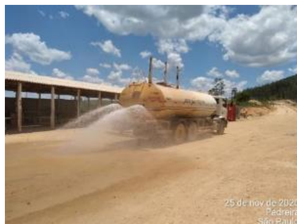
Foto 373 – Umectação nas vias internas. (Data:25/11/2020)
