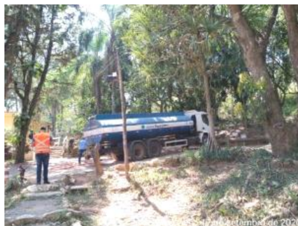
Foto 125 – Abastecimento da caixa d'água do canteiro administrativo. (Data:17/09/2020)
