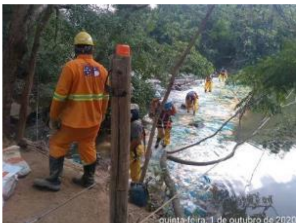
Foto 274 – Implantação da soleira próximo ao SAAE. (Data:01/10/2020)
