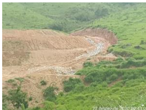
Foto 333 – Cacimbas regularizadas após as chuvas no bota-fora VII MD. (Data:22/12/2020)
