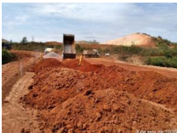
Foto 433 – Movimentação de terra na margem esquerda. (Data:03/11/2020)
