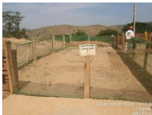
Foto 337 – Caixa SAO 2 no pátio de equipamentos. (Data:28/09/2020)
