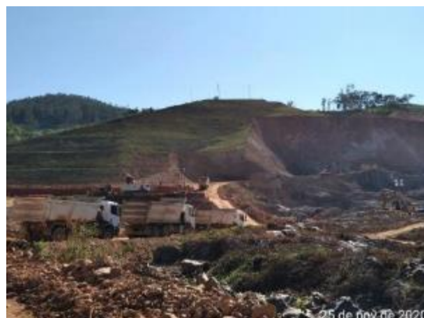
Foto 440 – Movimentação de terra na margem direita. (Data:25/11/2020)
