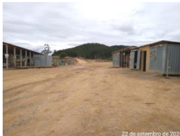
Foto 95 – Área do canteiro operacional limpa e organizada. (Data:22/09/2020)
