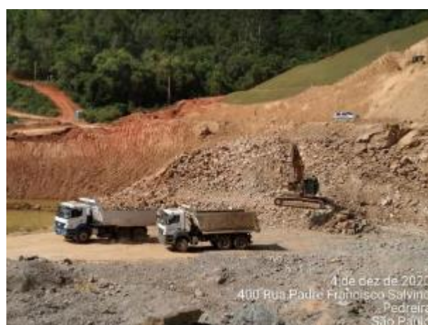
Foto 444 – Movimentação de rocha na margem direita. (Data:04/12/2020)
