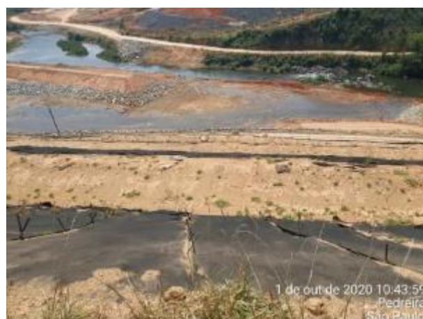
Foto 313 – Inspeção bota-fora I M.E. (Data:01/10/2020)
