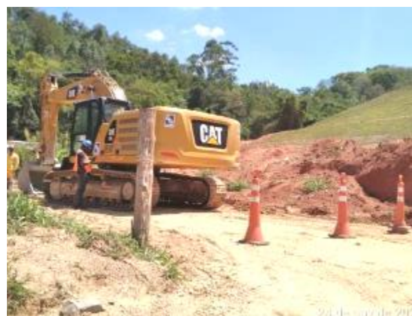
Foto 261 – Sinalização para manutenção de equipamento próximo a J1. (Data:24/11/2020)
