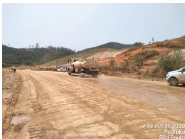
Foto 366 – Umectação nas vias internas (Data:07/10/2020)
