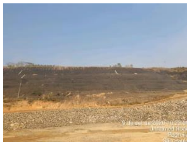
Foto 297 – Inspeção em bota fora I ME. (Data:09/09/2020)
