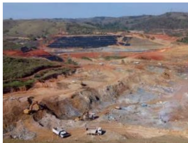
Foto 436 – Movimentação de terra e de rocha na margem direita. (Data:10/11/2020)
