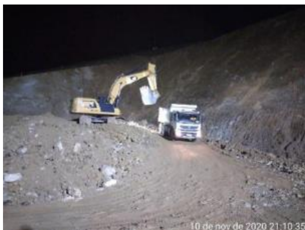
Foto 437 – Movimentação de terra na margem direita. (Data:10/11/2020)
