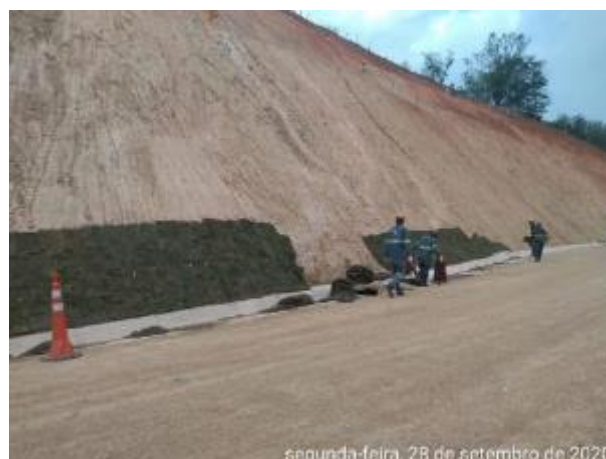
Foto 271 – Implantação de grama em placa no talude do acesso MD-03. (Data:28/09/2020)
