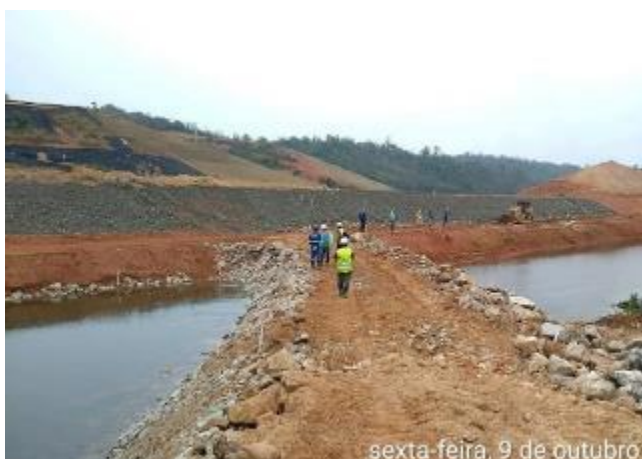
Foto 276 – Ensecadeira M1 com enrocamento no talude. (Data:09/10/2020)
