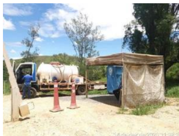
Foto 355 – Retirada de efluente de banheiro químico. (Data:14/12/2020)
