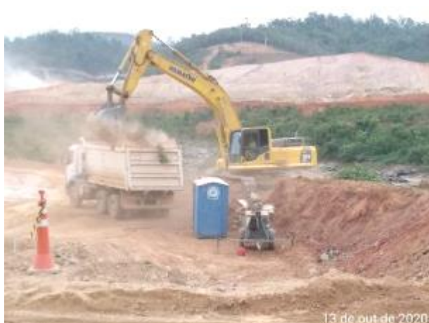
Foto 429 – Movimentação de terra na margem direita. (Data:13/10/2020)
