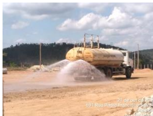
Foto 369 – Umectação nas vias internas. (Data:21/10/2020)
