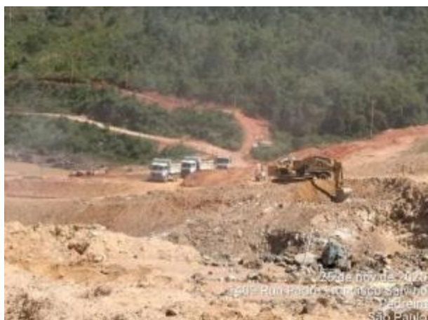
Foto 439 – Movimentação de terra na margem direita. (Data:25/11/2020)
