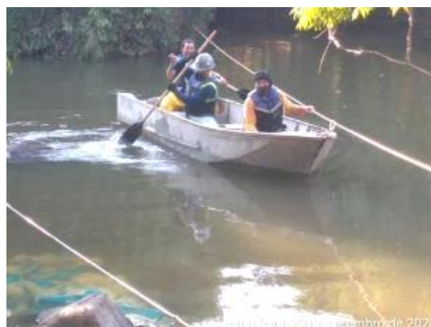
Foto 466 – Instalação da linha de vida para atividade. (Data:29/09/2020)
