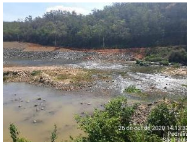
Foto 149 – Final do canal de desvio. (Data:26/10/2020)
