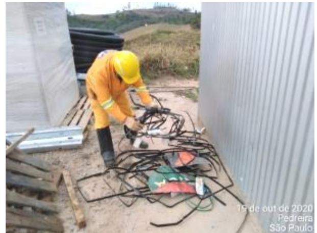
Foto 101 – Organização em frente de serviço do canteiro operacional. (Data:19/10/2020)
