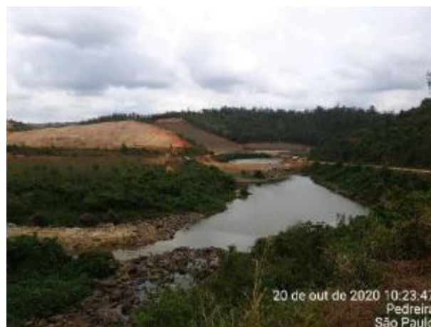
Foto 147 – Implantação da ensecadeira de jusante. (Data:20/10/2020)
