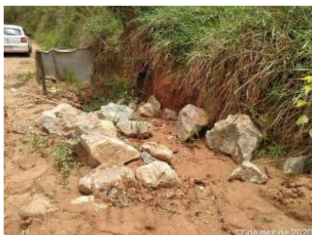
Foto 324 – Inspeção drenagem provisória existente em via externa. (Data:07/12/2020)
