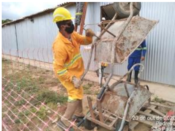
Foto 104 – Limpeza e organização na área do almoxarifado. (Data:20/10/2020)
