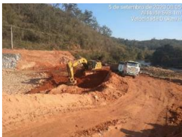
Foto 423 – escavação do canal de desvio. (Data:05/09/2020)
