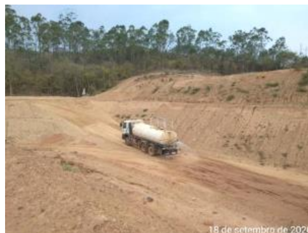
Foto 361 – Umectação nas vias internas. (Data:18/09/2020)
