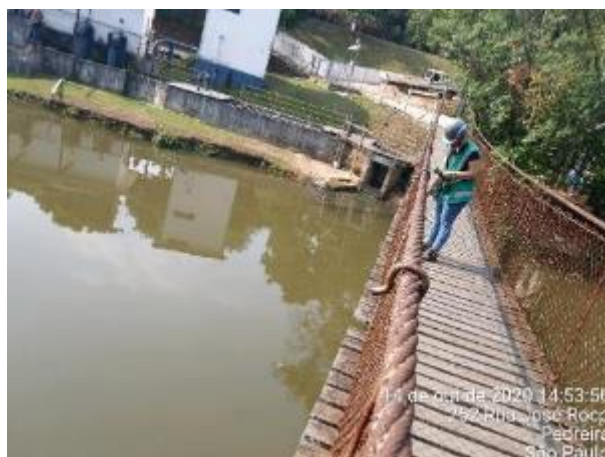
Foto 478 – Captação do SAAE Pedreira. (Data:14/10/20)
