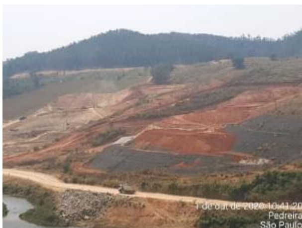
Foto 310 – Inspeção bota-espera do núcleo MD. (Data:01/10/2020)
