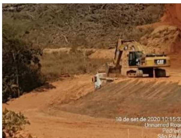
Foto 424 – Escavação do canal de desvio. (Data:10/09/2020)
