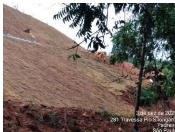
Foto 323 – Inspeção em talude gramado na M.D. 03. (Data:03/12/2020)
