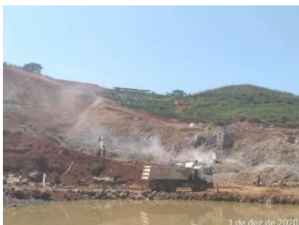
Foto 441 – Movimentação de rocha e terra na margem direita. (Data:01/12/2020)
