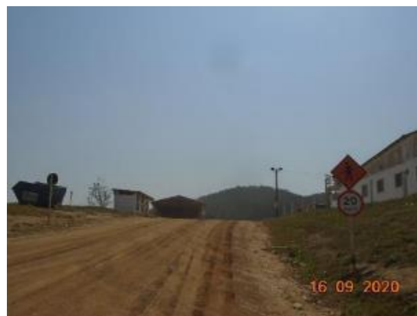
Foto 251 – Sinalização interna no acesso ao canteiro operacional. (Data:16/09/2020)
