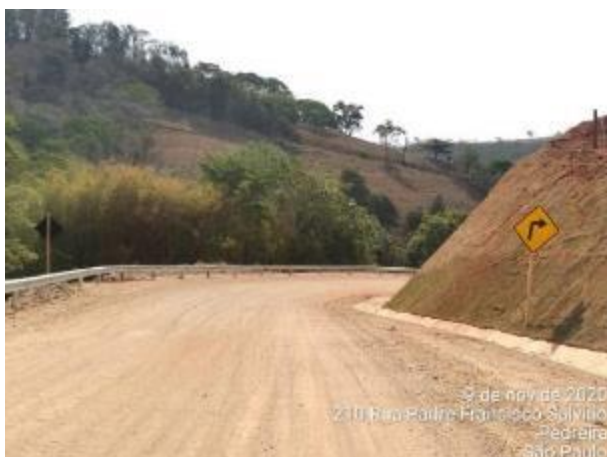
Foto 242 – Sinalização sobre curva acentuada a direita no acesso da MD-03, estrada municipal. (Data:09/11/2020)
