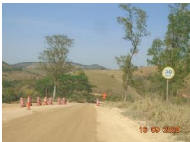
Foto 252 – Sinalização de velocidade máxima permitida em via interna. (Data:16/09/2020)
