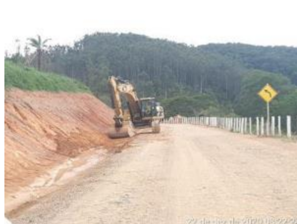
Foto 335 – Regularização de drenagem provisória no acesso da MD01. (Data:22/12/2020)
