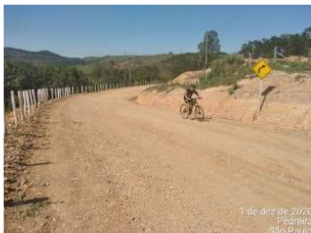
Foto 246 – Sinalização de curva acentuada a direita no acesso da MD-03. (Data:01/12/2020)
