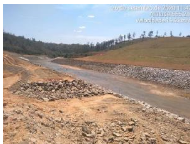
Foto 273 – Cacimba seguida de drenagem provisória próximo ao canal de desvio. (Data:26/09/2020)
