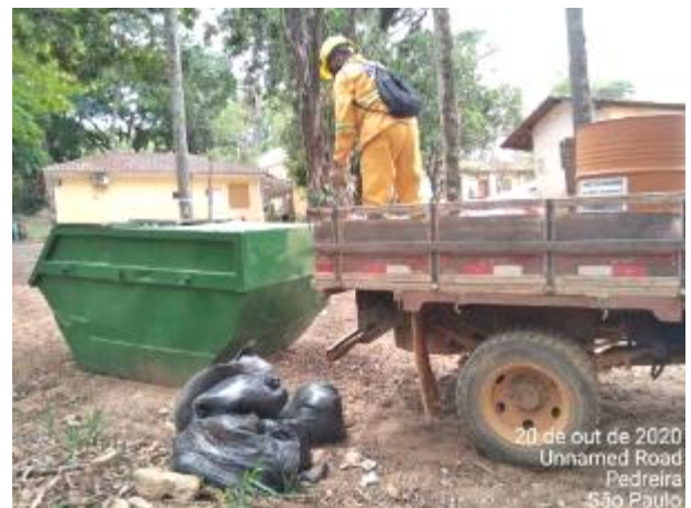
Foto 105 – Limpeza e organização no canteiro administrativo. (Data:20/10/2020)
