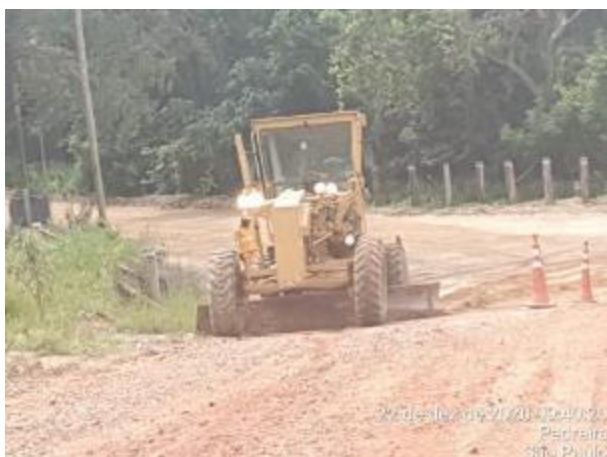
Foto 334 – Regularização do acesso da MD01. (Data:22/12/2020)
