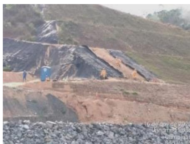
Foto 318 – Manutenção na proteção de talude no bota-fora I ME. (Data:16/11/2020)
