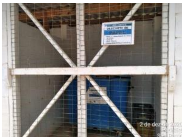
Foto 418 – Baia de resíduos de papel no canteiro operacional. (Data:02/12/2020)
