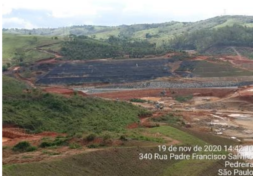
Foto 457 – Bota-fora I margem esquerda. (Data:19/11/2020)
