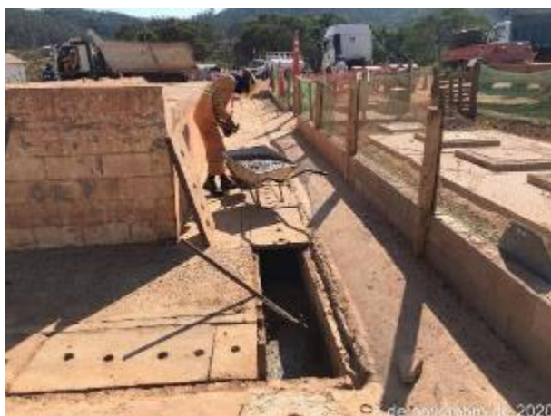
Foto 340 – Limpeza na calha da Caixa SAO 2 do pátio de manutenção. (Data:05/11/2020)
