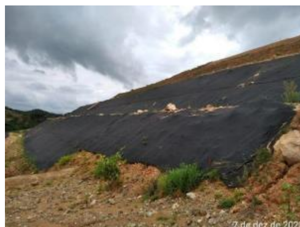
Foto 325 – Inspeção bota-fora IV M.D. (Data:07/12/2020)
