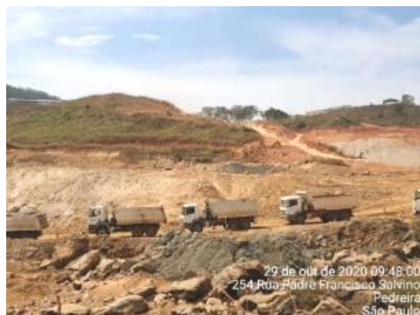
Foto 432 – Movimentação de terra na margem direita. (Data:29/10/2020)
