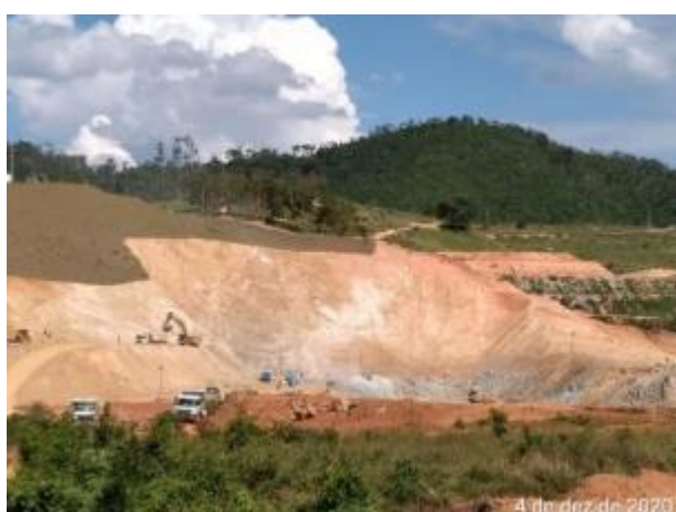
Foto 443 – Movimentação de terra margem direita. (Data:04/12/2020)
