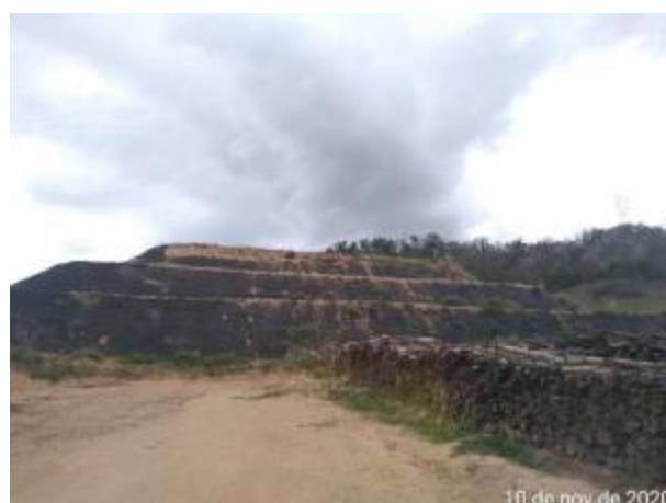
Foto 316 – Inspeção bota-fora III MD. (Data:10/11/2020)
