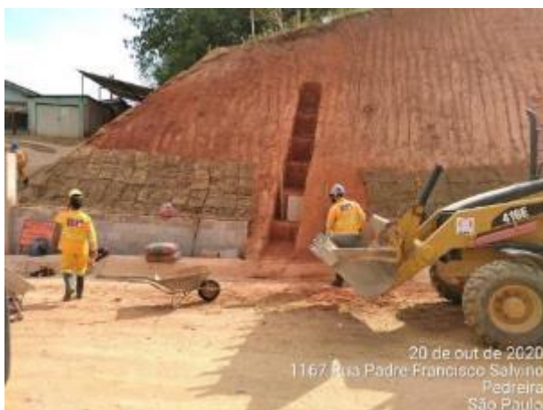
Foto 278 – Construção de escada hidráulica no talude da MD03. (Data:20/10/2020)
