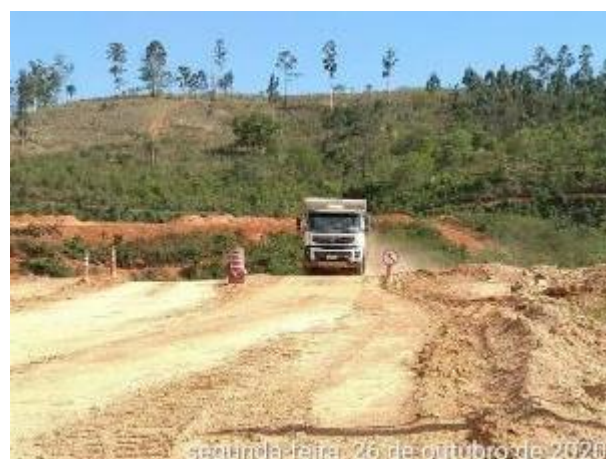
Foto 257 – Sinalização de cones para separar os sentidos de via interna próximo a área do eixo. (Data:26/10/2020)
