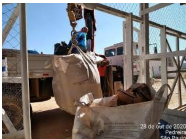
Foto 408 – Retirada de resíduos recicláveis no canteiro operacional. (Data:28/10/2020)
