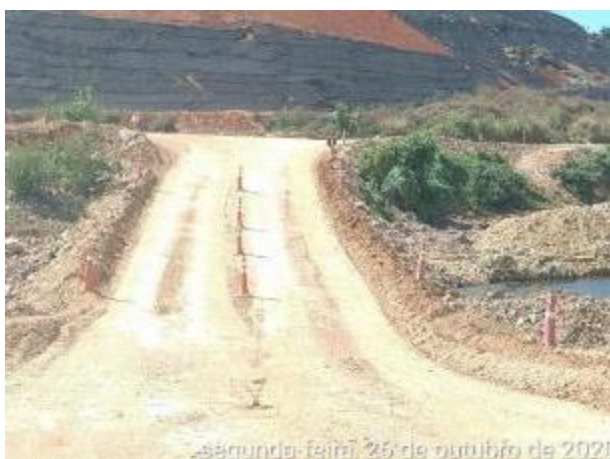
Foto 254 – Sinalização em cone para separar os sentidos da via interna. (Data:26/10/2020)
