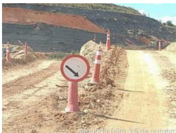
Foto 256 – Sinalização de sentido obrigatório em via interna na margem esquerda. (Data:26/10/2020)
