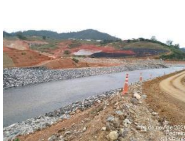
Foto 285 – Canal de desvio do rio Jaguari com enrocamento implantado. (Data:14/11/2020)
