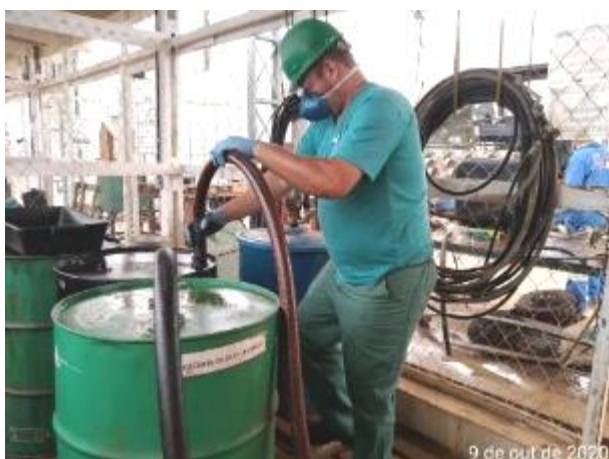
Foto 72– Retirada de óleo queimado. (Data:09/10/2020)
