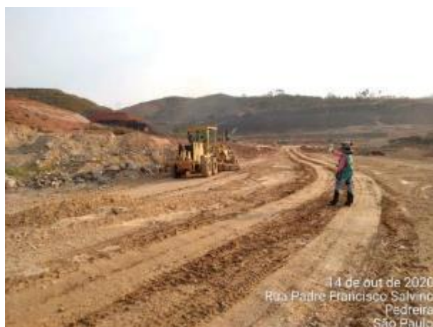
Foto 378 – Monitoramento de fumaça preta em equipamento. (Data:14/10/2020)
