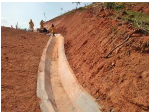
Foto 280 – Drenagem no talude do acesso da MD03. (Data:30/10/2020)
