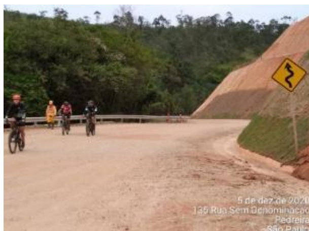
Foto 248 – Sinalização de pista sinuosa a esquerda na MD-03. (Data:05/12/2020)
