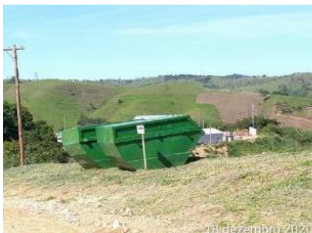
Foto 420 —Caçambas de resíduo comum no canteiro operacional. (Data:18/12/2020)
