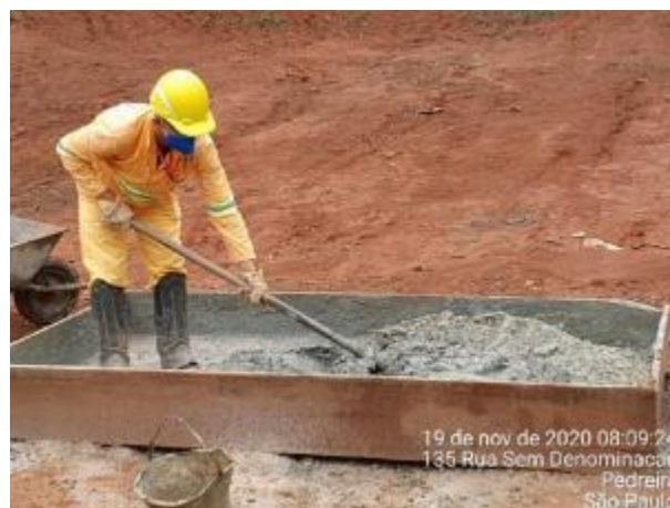
Foto 75– Mistura manual de concreto. (Data:19/11/2020)
