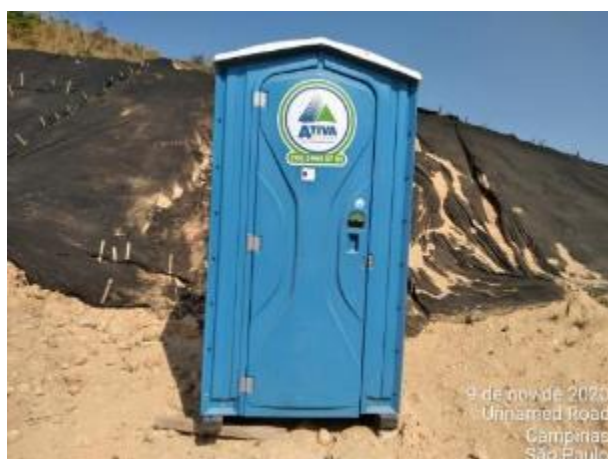
Foto 352 – Banheiro químico instalado na frente de serviço no bota-fora I M.E. (Data:09/11/2020)
