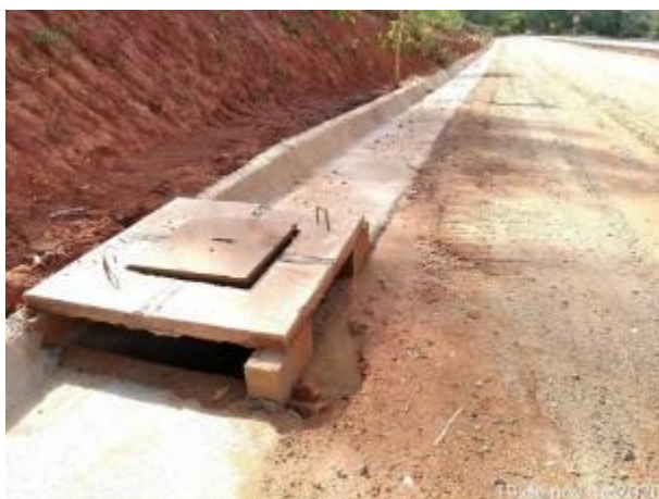
Foto 286 – Drenagem do acesso da MD03. (Data:19/11/2020)
