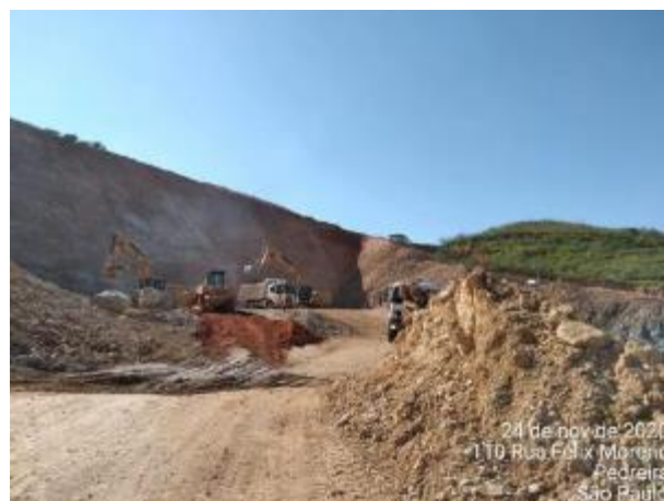
Foto 438 – Movimentação de terra e rocha na margem direita. (Data:24/11/2020)
