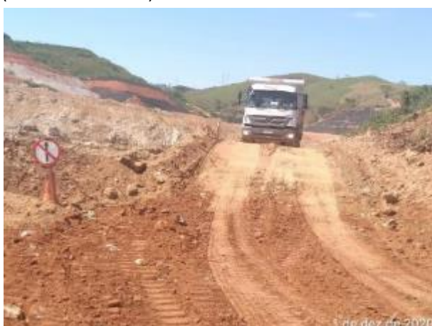
Foto 262 – Sinalização de sentido proibido em via interna na margem esquerda. (Data:01/12/2020)
