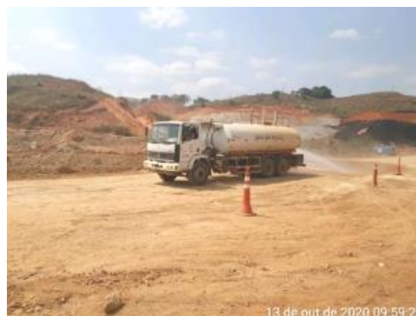
Foto 367 – Umectação nas vias internas. (Data:13/10/2020)
