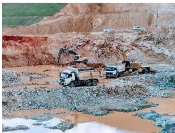
Foto 447 – Movimentação de terra e rocha na margem direita. (Data:12/12/2020)
